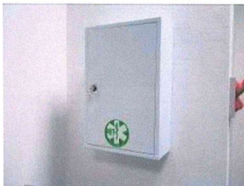
Foto 9: cassetta Primo soccorso
